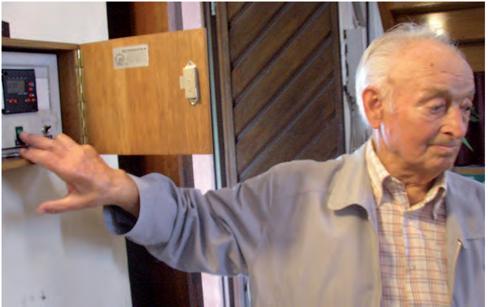
Mesner Heinrich Leßle an der elektrischen Läuteanlage, 2013
