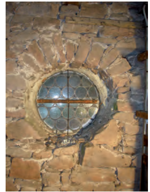
Mauerwerk des oberen Rundfensters
