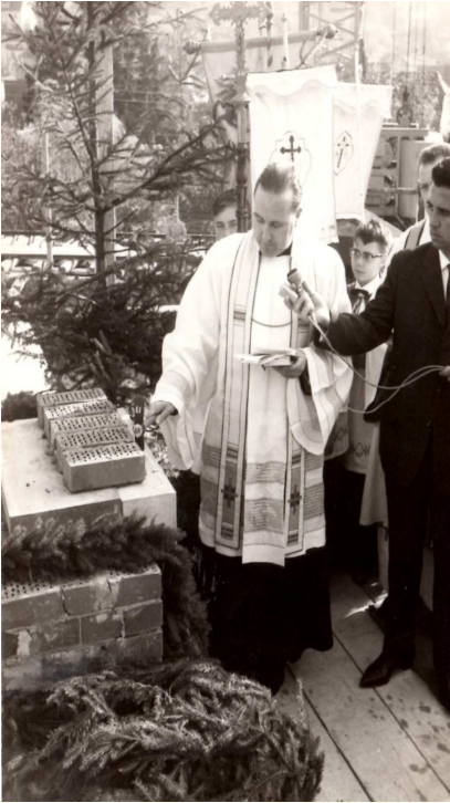
Pfr. Krieg bei der Grundsteinlegung
